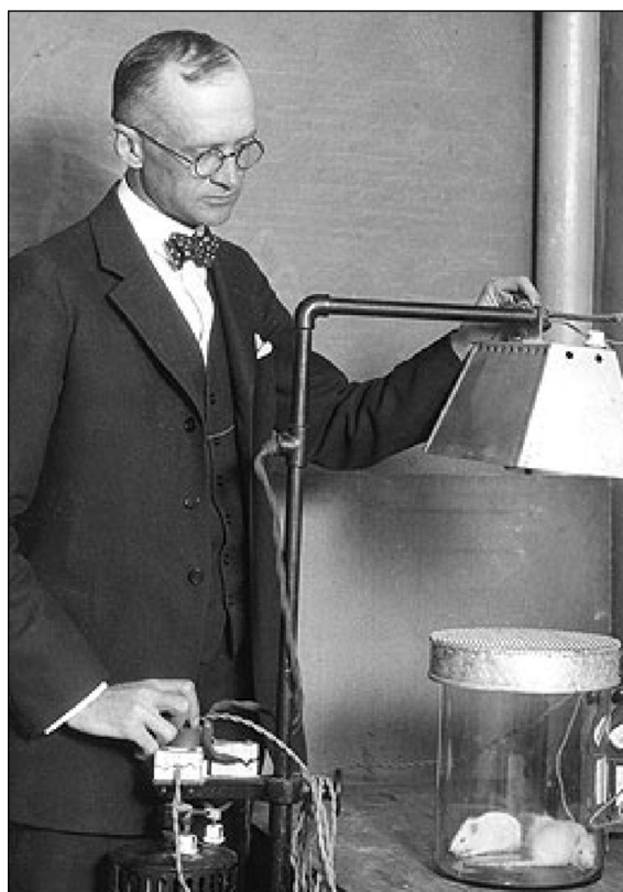
Figura 17. Professor Harry Steenbock junto do sistema que concebeu para a prevenção do raquitismo em ratos, por irradiação luminosa e que, posteriormente, veio a ser desenvolvido para a fortificação do leite com vitamina D. (Crédito: Courtesy of University of Wisconsin - Madison Archives).
